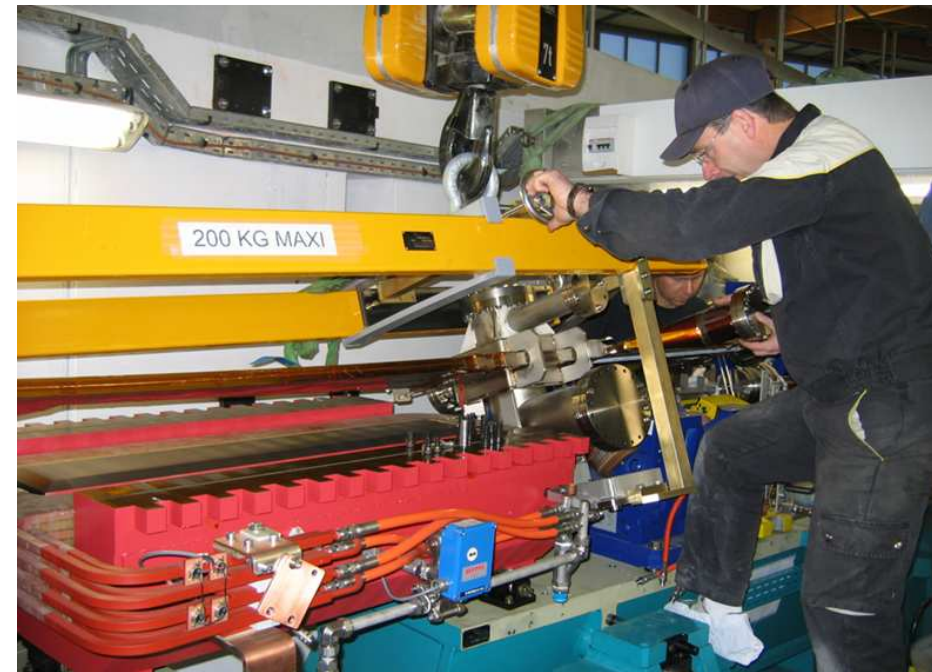
Installation de la chambre à vide du dipôle
